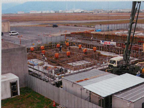
施設の建設工事の様子（イメージ）
