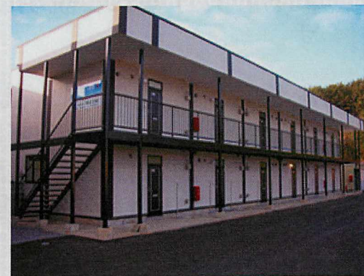
車力通信所に隣接する借上住宅
