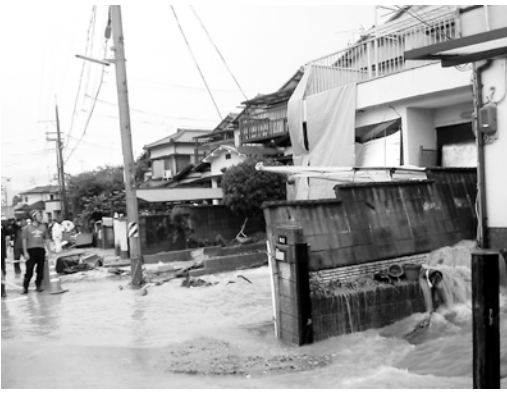
弥陀次郎川決壊で被災した住宅
