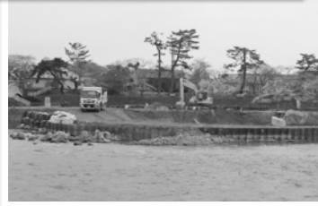
桜の木等を伐採し、工事中の府立宇治公園
