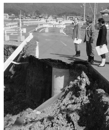
園部町内の陥没道路（10月24日）
