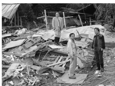
宮津市の家屋全壊現場（10月21日）
