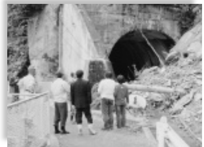
美山町の大野トンネル入口土砂崩れ (10月24日)
