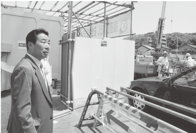
5月14日、(生活関連公共事業推進連絡会の)公共工事現場調査に同行し、府発注工事現場で、労働者の賃金、下請契約などについて調査しました。
