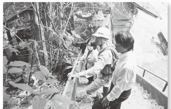
7月26日がけ崩れ現場調査
