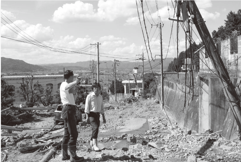
7月17日、豪雨被害の亀岡市曾我部町を調査
