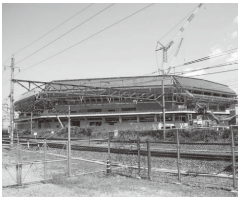
建設中のスタジアム
