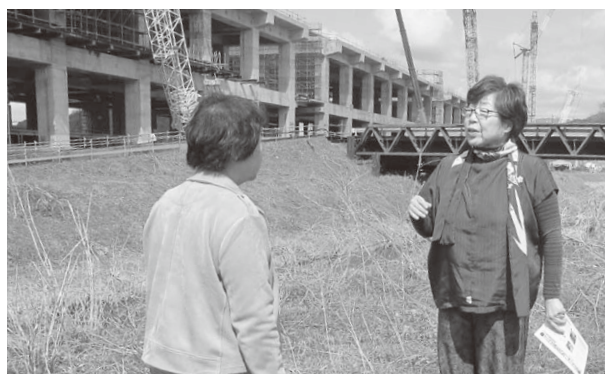
北陸新幹線敦賀駅工事を調査(3月14日)
