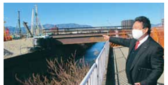
代表質問では、大手業者優先の開発を厳しく批判しました。写真は向日町駅東口再開発現場の調査(1月18日)。
