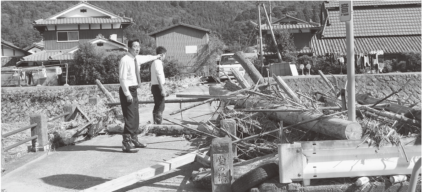
台風18号被害調査 (9月18日)
