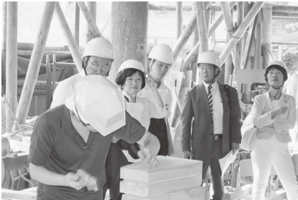
清水寺で文化財修復工事を調査(6月10日)
